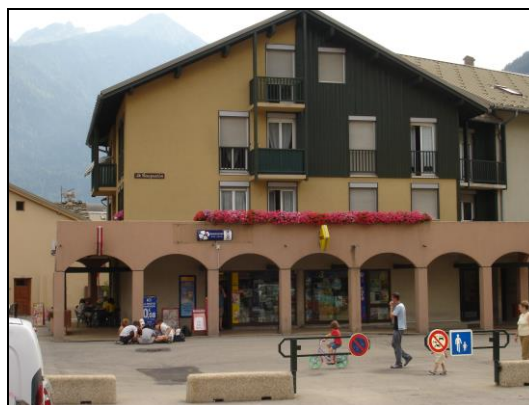
Photo 28 - Un immeuble rénové de la place de l'Hôtel de Ville, à Modane
