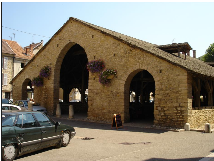
Photo 36 - La halle de Crémieu
