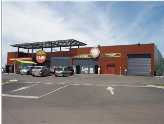
Photo 7 - L'évolution architecturale des nouvelles grandes surfaces alimentaires périphériques : Grand Frais dans la ZAC des Charmes à Paray-le-Monial
