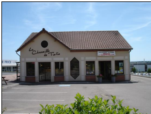
Photo 9 - Des petites surfaces périphériques en formes de pavillons de banlieue, dans la ZAC des Charmes à Paray-le-Monial
