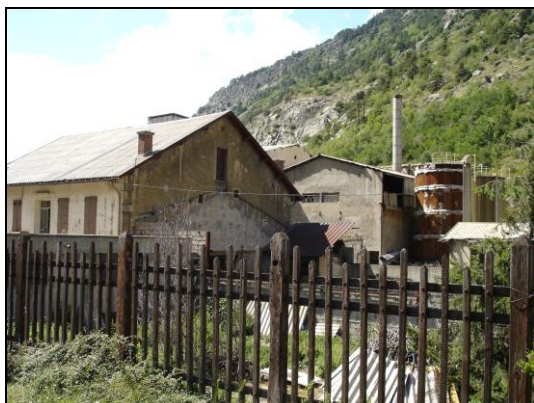
Photo 15 - L'ancienne friche industrielle Matussière à l'entrée de Modane-Fourneaux
