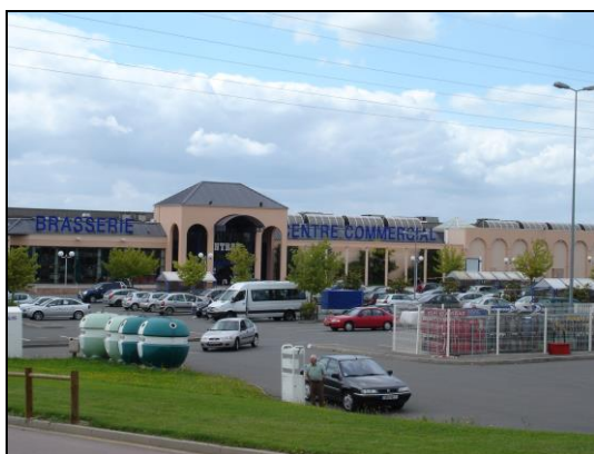
Photo 5 - Exemple d'amélioration architecturale : l'hypermarché E. Leclerc de la ZAC du Champ Bossu à Paray-le-Monial
