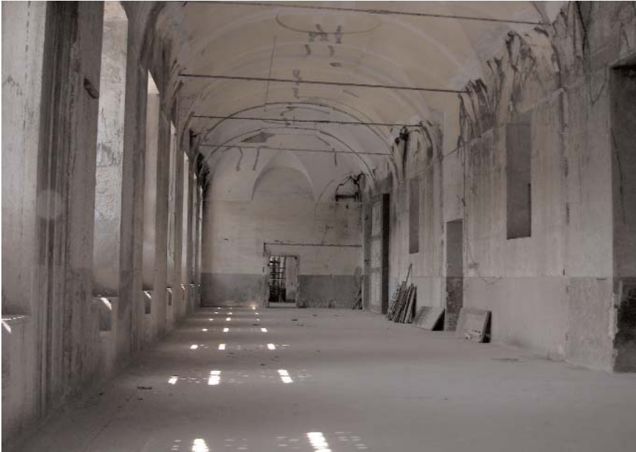
Vue d'un espace intérieur (dortoir), piano terra côté piazza, cour Ouest. Foto: Nicolas Detry, 2005
