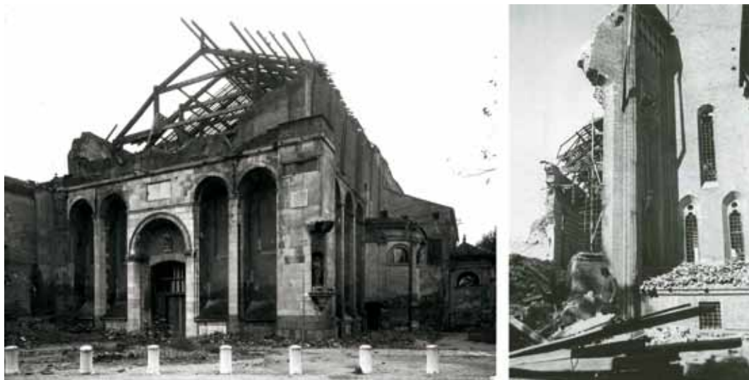
Fig. 4 – l'église San Giovanni Eremitani vers 1944. On note le hors-plomb du mur Sud, la grande lacune dans le haut de la façade Ouest, la charpente de Fra Giovanni en partie détruite. À droite, la chapelle Ovetari abritant les fresques d'Andrea Mantegna, état en 1944 (Venise Ministero dei beni e delle attività culturali e del turismo - Archivio Fotografico de la SBAP).
